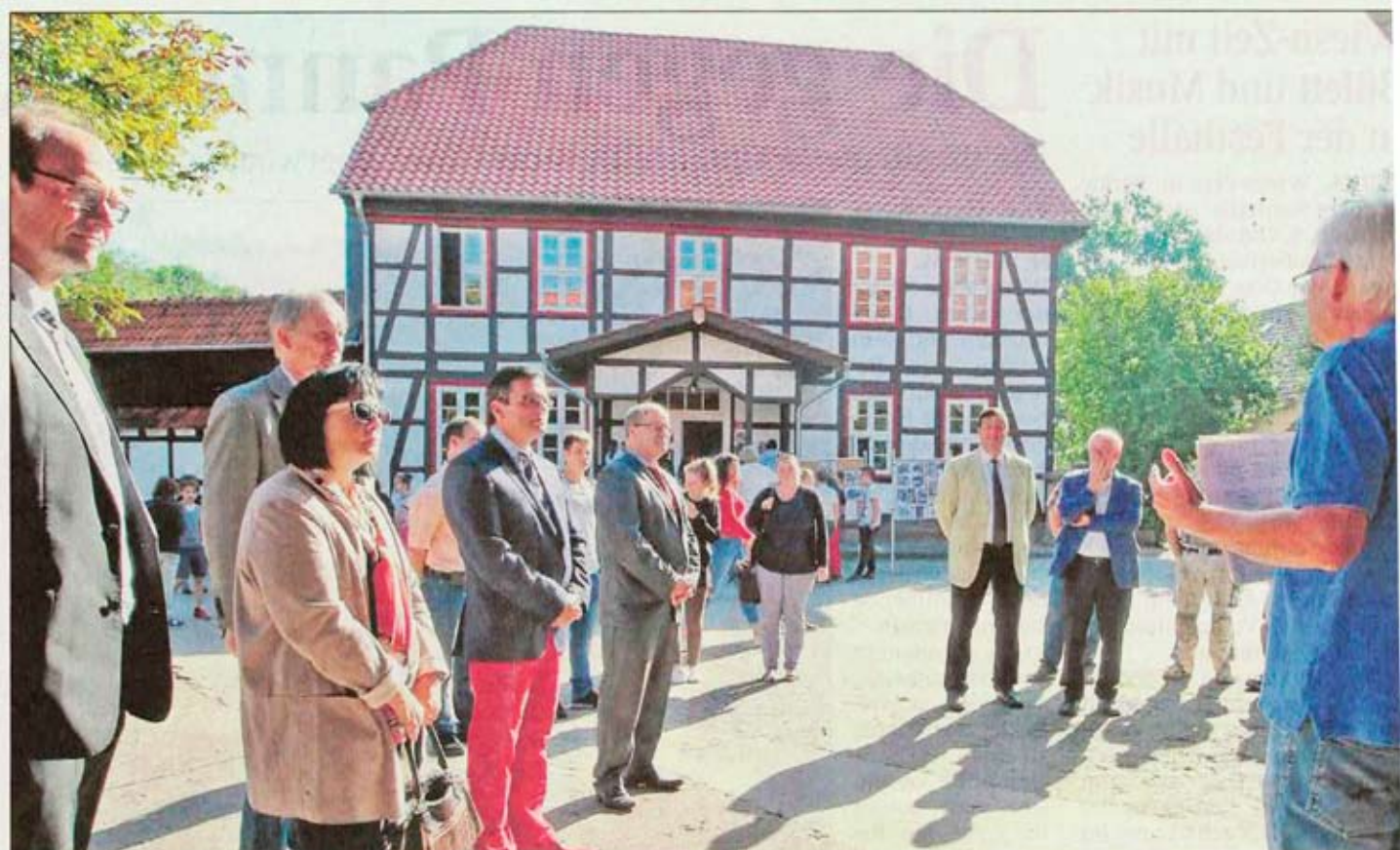
Neues Dach und neue Fassade: Die Sanierungsarbeiten am Haupthaus des internationalen Schulbauernhofs in Hevensen sind abgeschlossen. Axel Unger (rechts) begrüßte die Sponsoren und Helfer.
